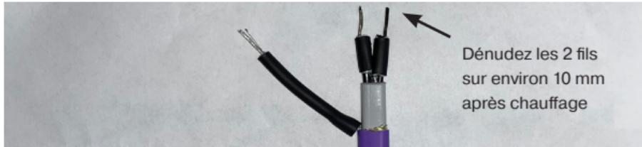
Installez une gaine thermorétractable 12/3x17 mm sur l'isolation centrale et chauffez
