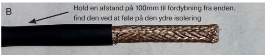
Fjern den midterste/inderste isolering på varmekablet
