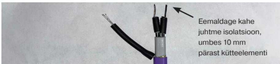
Paigaldage 12/3x17 mm kuumakahhanemistoru keskmise isolatsiooni peale ja kuumutage
