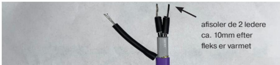
Installer krympefleks 12/3x17mm over den midterste isolering og varm
