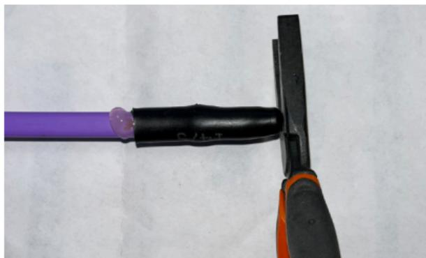
Eemaldage toitekaabli välimine isolatsioon, lühendage maandusjuhet ja eemaldage juhtmete otstelt 10 mm isolatsiooni
